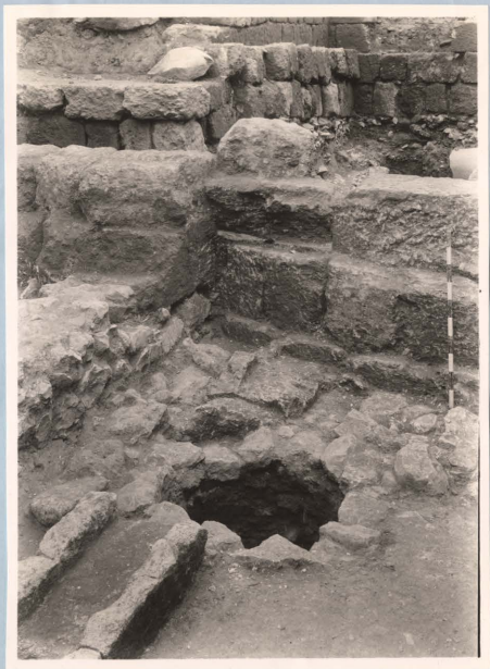
Fig. 10 . (3073). 16 P. Relation entre le mur circulaire, le puits médiéval , le caniveau hellénistique et le mur de l'atelier du I. siècle A.D.
